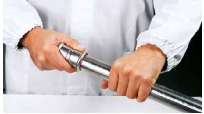
Joonis 31 – Toru sisestamine pressliitmikusse
