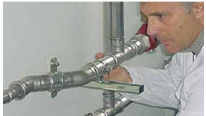
Joonis 33 – pressühenduse kontrollimine
