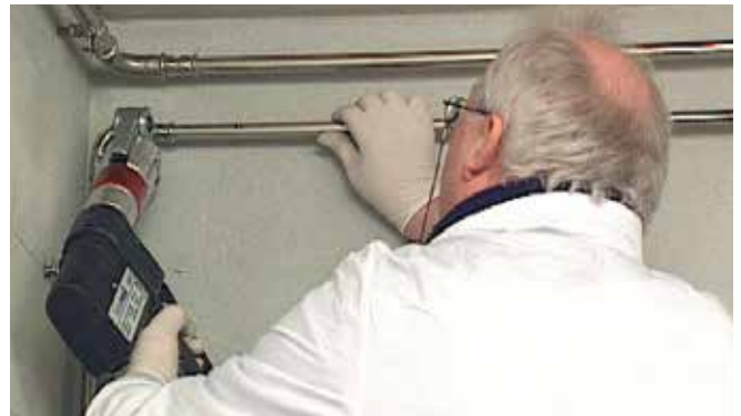
Joonis 32 – Pressühenduse loomine
